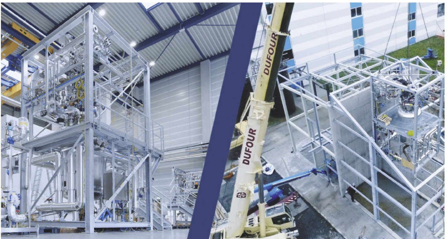
Modulmontage in zweckgebundenen Hallen bei Ekato in Schopfheim (links) und Installation des Reaktormoduls beim Betreiber (rechts)
